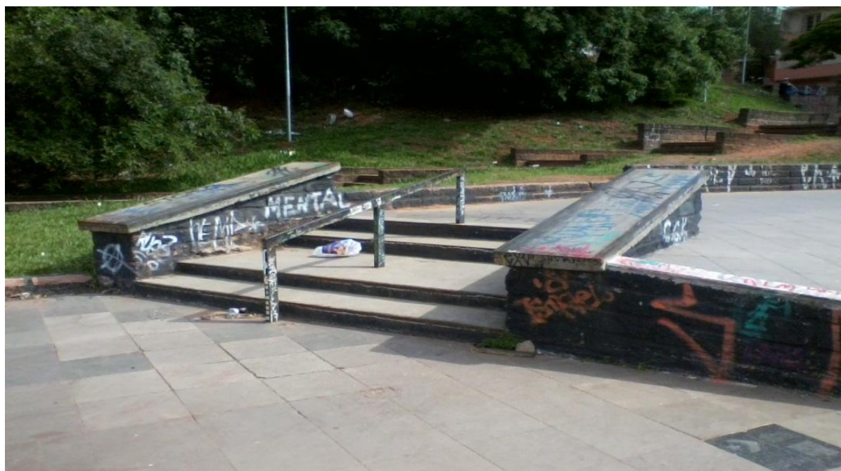
FIGURA 1 – ESCADA E CORRIMÃO. Acervo do próprio pesquisador.
